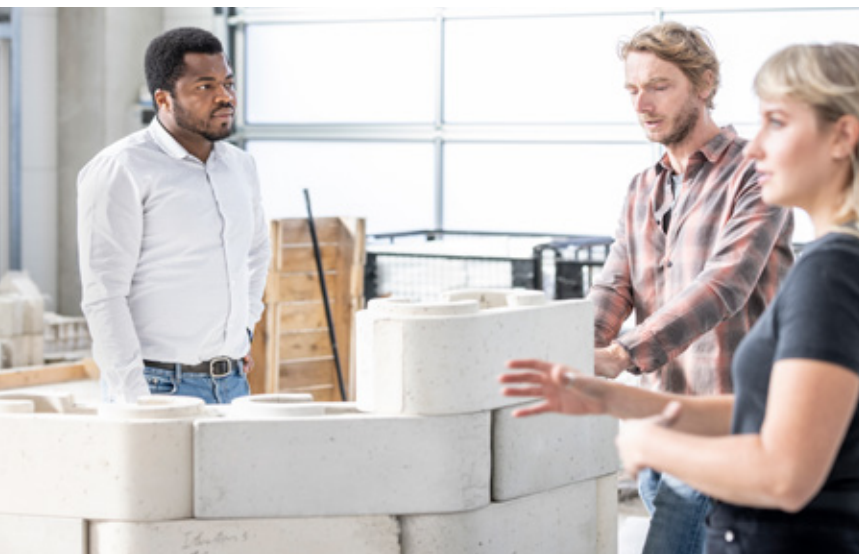
Schalungssystem „TwistBlock Moulds“
