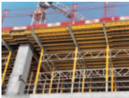
MULTIPROP hegnet yder den nød- vendige stabilitet til kantborde.
