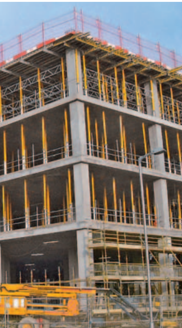
En optimal kombination: MULTIPROP dækstøtte med hegn, drager MPB 24 som ri- deplanke og GT 24 som strø.
