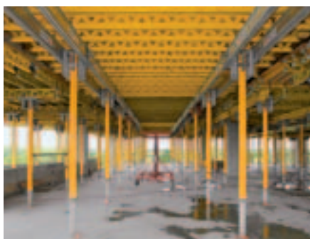
MPB 24 drageren brugt som dob- belt rideplanke til dækbord.
