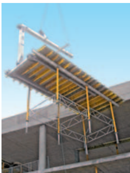
Med PERI kranaffel kan dæk, op til 8 m i længden og med en vægt på op til 1,75 t, flyttes.
