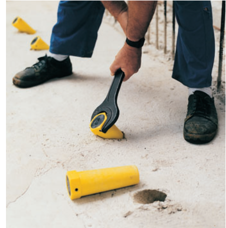
... og nem afmontering af fremløbskoblingen ved betonen.
