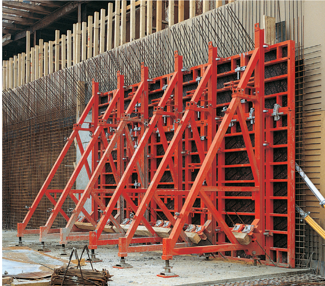
Støttebuk SB-B, C og TRIO, støbehøjde 3,90 m.
