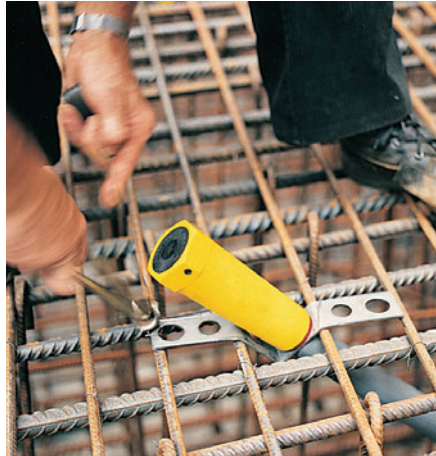
Enkel montering af forankring på armering ...
