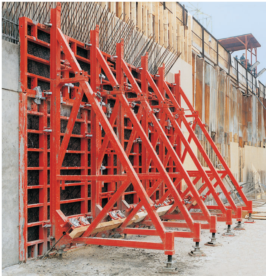
Støttebukke SB-B og SB-C med PERI TRIO rammeform. Støbehøjde 3,50 m.
