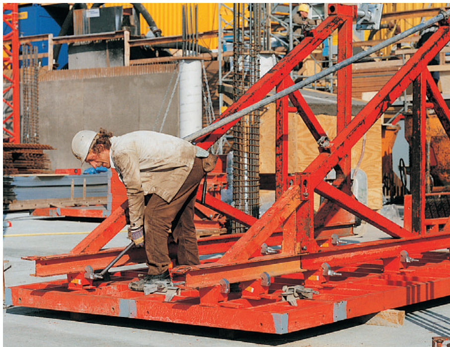
Montering af støttebuk SB-A, B og C, på liggende TRIO forme.
