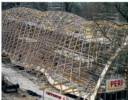
MULTIPROP Støtter bar trækonstruktionen og medførte at gitterskallen fik en buet form.
