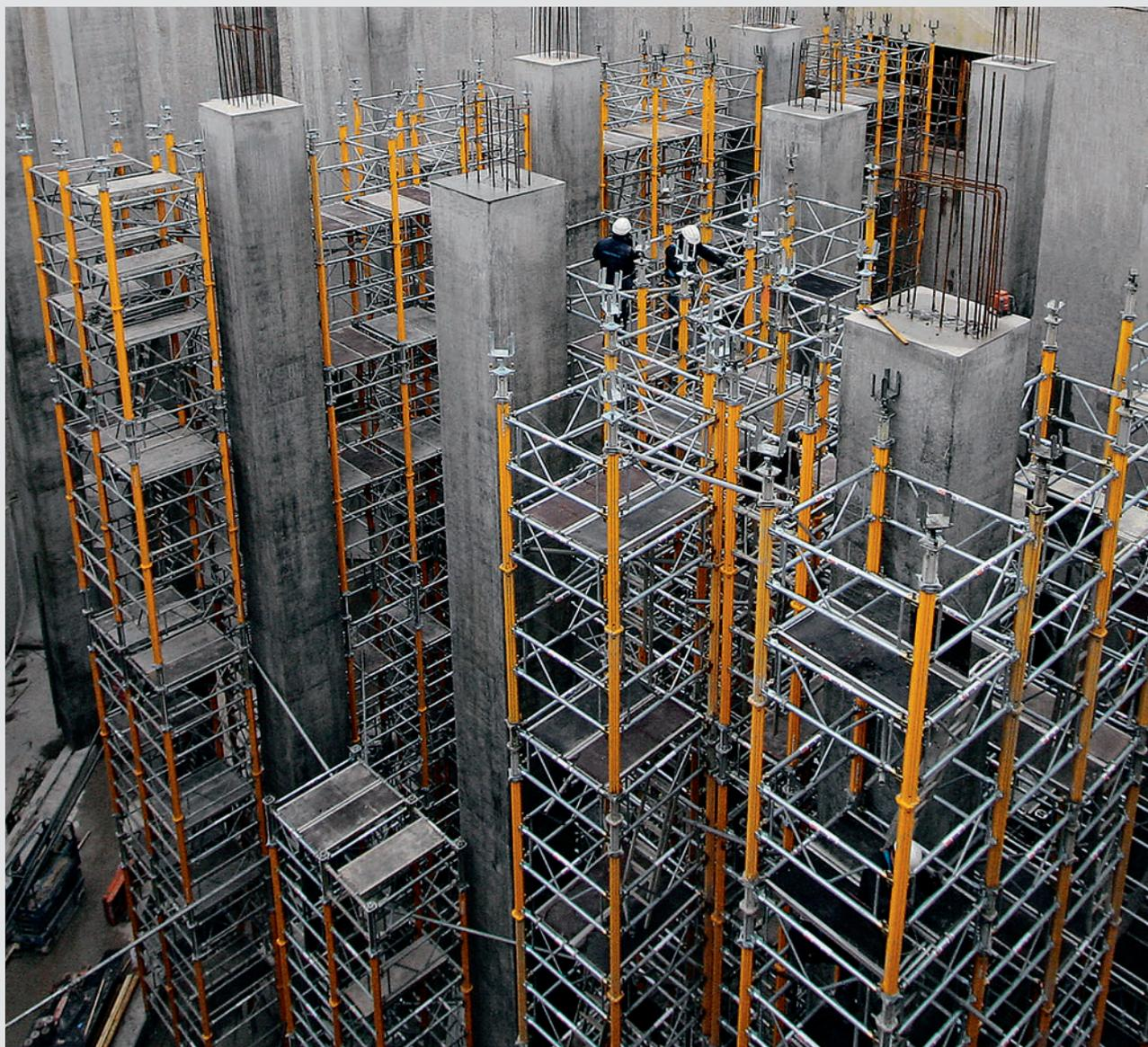
Dæk med længder på 150 cm og 225 cm – med eller uden luger til stiger – muliggør opstilling af støtte-tårne med montageplatforme med adgang via teleskopstiger. Dækkene er designet til en maksimal belastning på 200 kg/m<sup>2</sup>.
