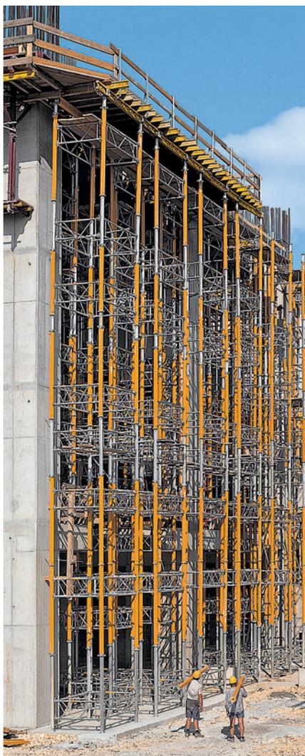
MULTIPROP støttetårne til udkragede dæk i 20 m højde.
