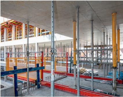
RCS MP materialeplatformens RCS skinner er fastspændt med MULTIPROP dækstøtter mellem to etagedæk.
