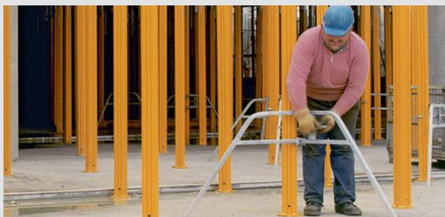
Universaltrebenet bruges som hurtig opstillingshjælp og passer til alle dækstøtter fra Ø 48 mm til 120 mm.
