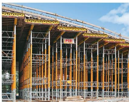
MULTIPROP understøtningstårne som er en underkonstruktion for projektspecifikke dækborde.
