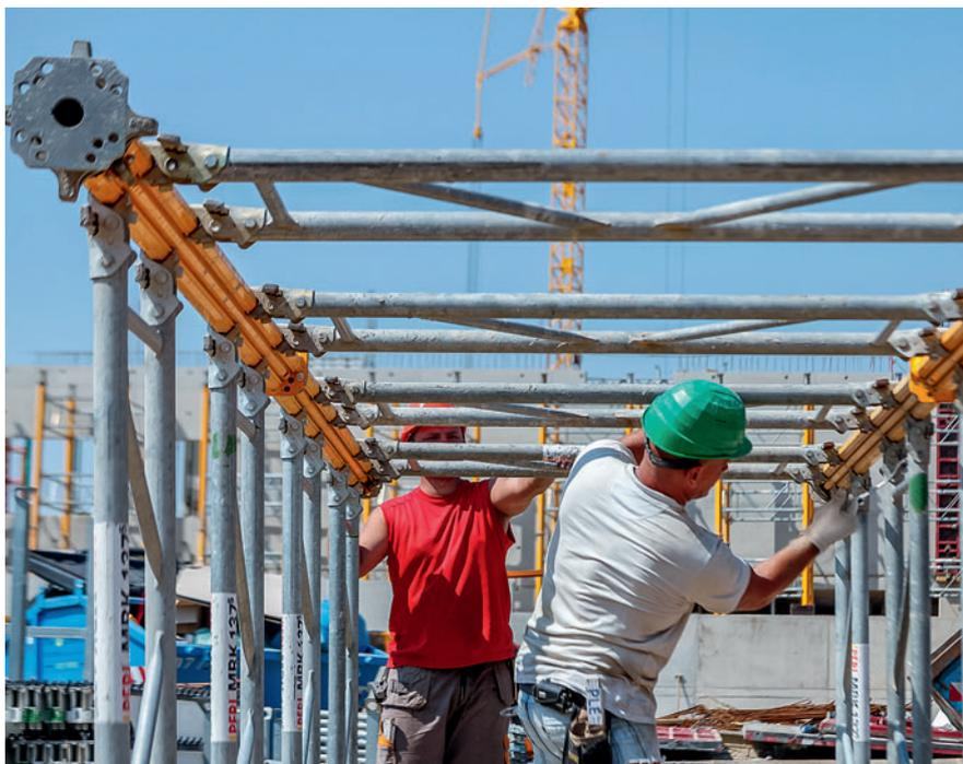
Til opførelse af et støttetårn anvendes MULTIPROP hegn med den fastmonterede kile på MULTIPROP støtten. Montagen af MRK hegn kan foretages på såvel yder- som på inderrøret uden at dette påvirker geometrien.
