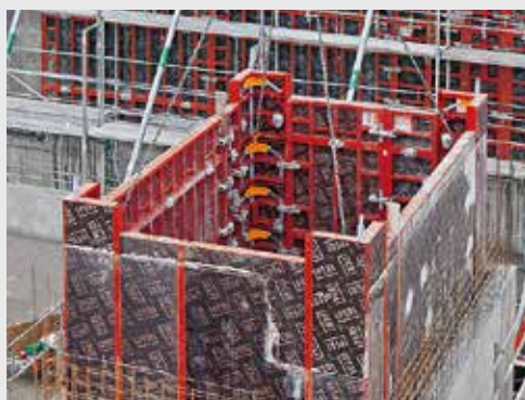
Når skakthjørnet løsnes og løftes med en kran, opstår der en afforskallingsafstand på 35 mm ved hver side.
