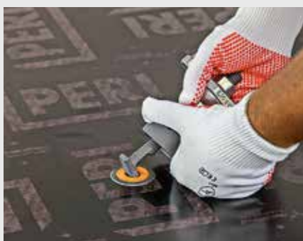
Udskiftning af den aftagelige forsegling fra MX 15...
