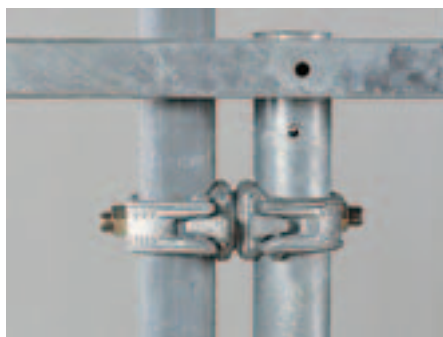
Nemt at montere stilladsrørene Ø 48,3 mm, med koblinger DK 1.
