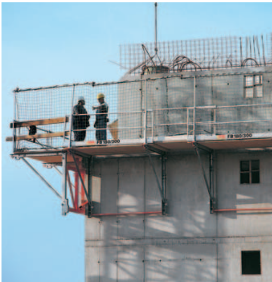
Foldeplatform FB 180-3 som beskyttelsesplatform ved tagudhæng.
