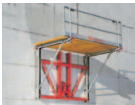
Hjørne-foldeplatform på en lige vægstrækning.
