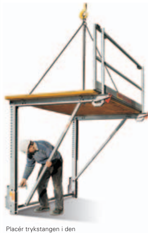
Trykstangen fastgøres med de fastmonterede bolte.
