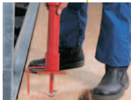
Endestolpen FBP, til rækværk, skrues i universalbeslaget (DW 15) i platformen.
