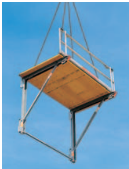
Fastgør 4-slingskæden i kranøjerne og løft op.
