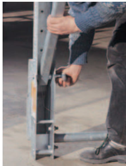
Trykstangen fastgøres med de fastmonterede bolte.
