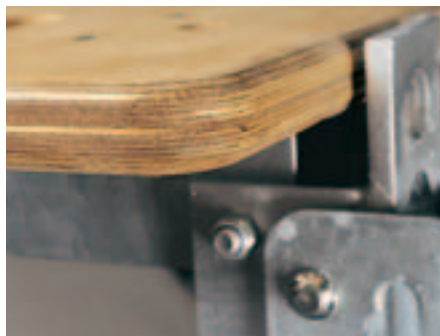
Det 45 mm tykke platformsdæk består af flere lag limtræsplader.
