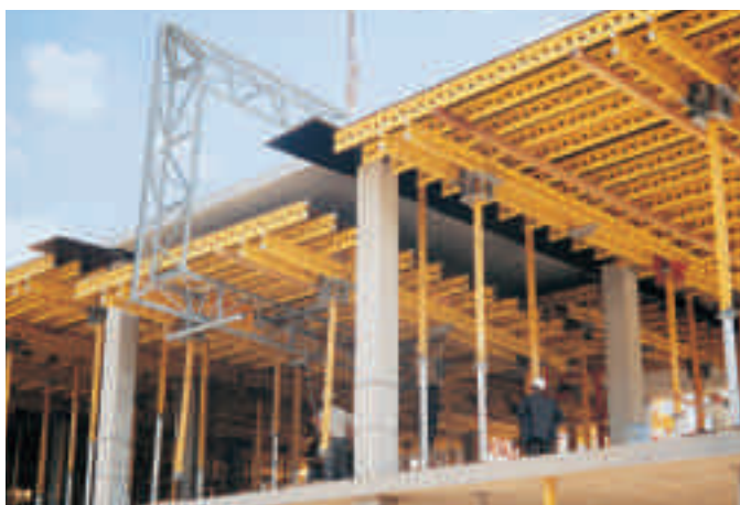
Flytning af 5,40 m x 7,00 m UNIPORTAL dækborde.
