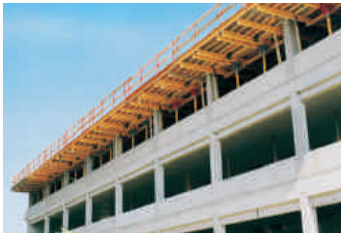
Udkragende UNIPORTAL dækbord med rækværk.
