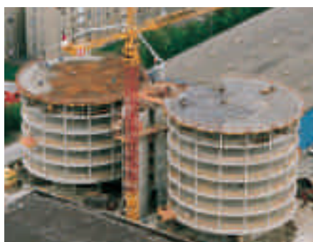
Trapezformede UNIportal dækborde til en rund kontorbygning.
