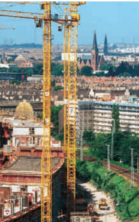
UNIPORTAL dækborde ved opførelsen af en administrationsbygning.
