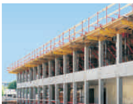
Dækborde med rækværk ved opførelse af en administrationsbygning.
