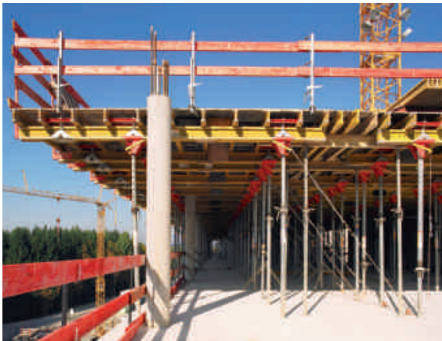
Udkragende Bordmodul VT. Synligt sikret med kæde.
