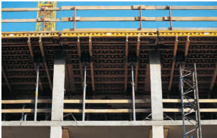
Rækværk med gelænderstolpe PD 8, art.nr. 019040.
