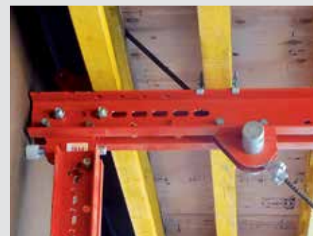
Spændaksel SRU med DW 15 ankerstav kan betjenes fra undersiden af broen.
