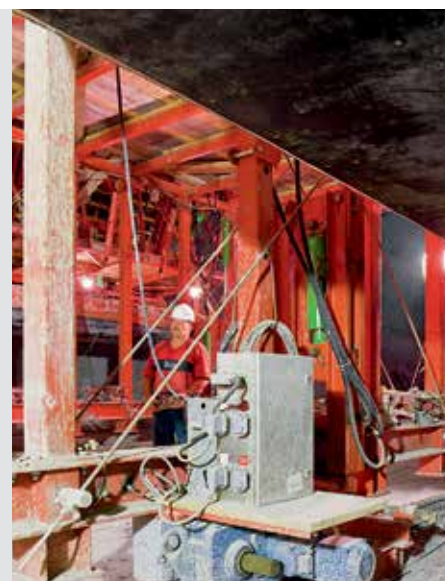
nør Konstruktionskittet og, om nødvendigt, planlagt i henhold til projektets krav.
