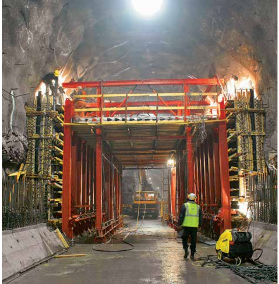
Den første sektion med bundplade og begyndelsen af væggen er allerede støbt.
