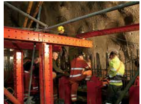
Systemkomponenter til vognen og det mobile form ophæng tillader fleksibel udnyttelse.
