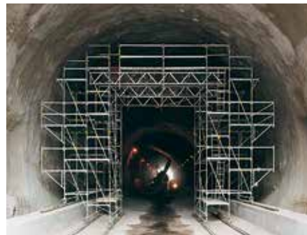
Stilladssystemet PERI UP tilbyder alle muligheder - fra simple trappetårne til en komplet forseglingsvogn.
