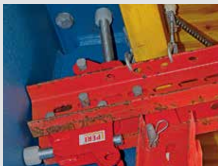
Støttespindler for optimal tilpasning til broens tværsnit med et indstillingsområde på +/- 10 cm.
