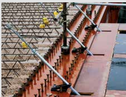
Ankerplade med rørmøtrik og DW 15 ankerstav betjenes fra oversiden af broen.
