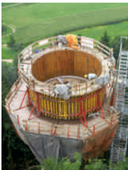
Rundforskalling med GRV på PERI KGF 240 klatrekonsoller.
