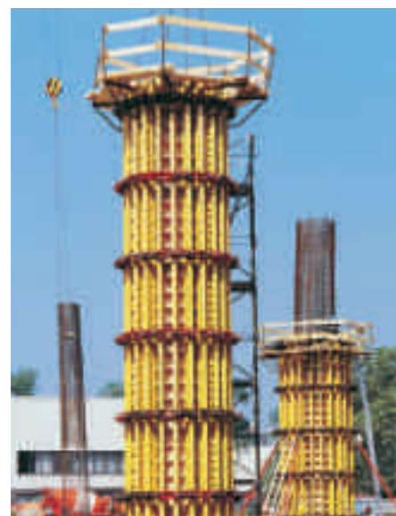
GRV i brug til konisk rundssøjleforskalling.
