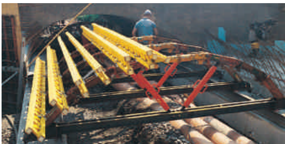
GRV Rundforskalling og ståldragere som selv bærende understøtning til buede broer.
