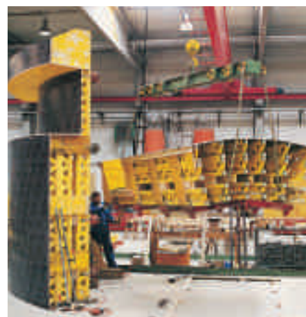
Selv komplicerede tværsnit til rensningsanlæg er ikke noget problem med PERI GRV.
