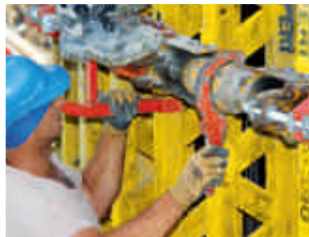
Justering af GSRV Rigel med spindel udføres med Hagenøgle.
