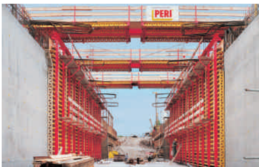
Tunnel omfartsvej B 311, Ertingen, Tyskland.
