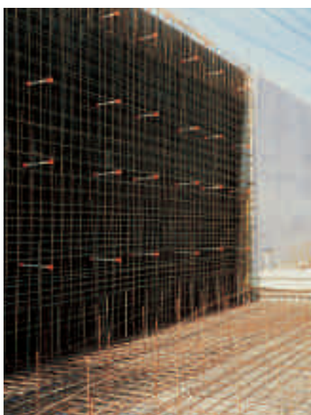
Tunnel i Häggsviksleden, Sverige.
