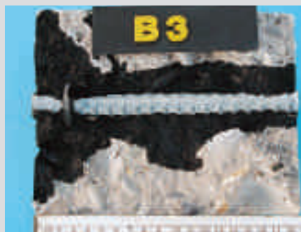
... og det indstøbte vandstop ikke holder tæt.
