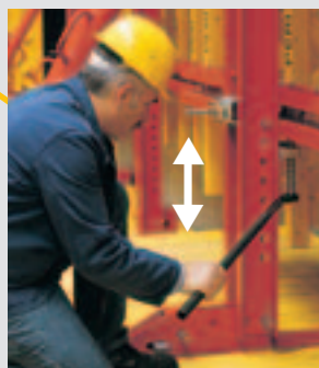
Vertikalindstilling af formen ved VARIO GT 24 med Justeringsenhed CB
