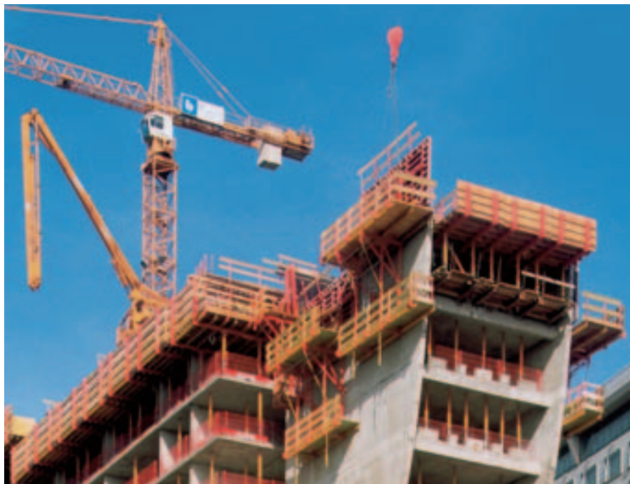
Hotelbyggeri CB 240 konsol komplet med finishplatform og TRIO.
