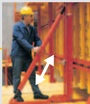
Præcis hældningsindstilling med spindel CB 164 – 224
