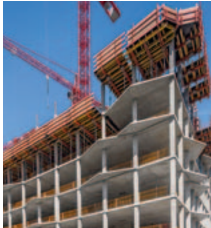
Dækborde med GT 24 drager og stålriger kan designes og samles, så de passer til de projektspecifikke geometrier. Dækbordet flyttes hurtigt og sikkert med en krangaffel til næste opstilling.
