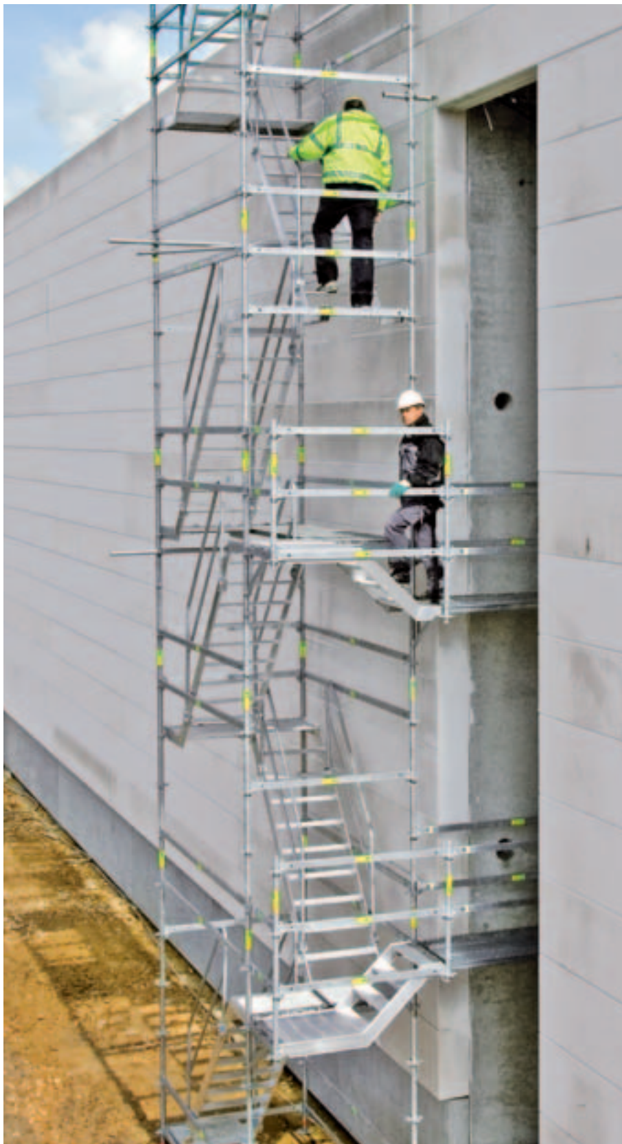
Højdetilpasningerne til bygningsåbninger bygges uafhængig af etagehøjde.
