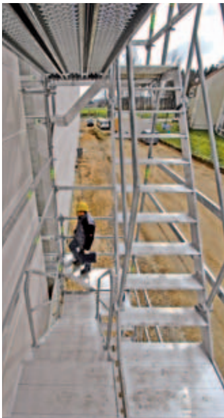
Højdetilpasningerne er placeret på siden, hvilket gør, at platformen er fri til op- og nedgang.
