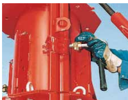
Sammenspændingsboltene med selvrensende sekskantet gevind er fastmonteret på søjleforskallings to halvdele.
