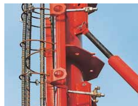
På hvert søjle element er en elementstøttetilslutning tilgængelig.
