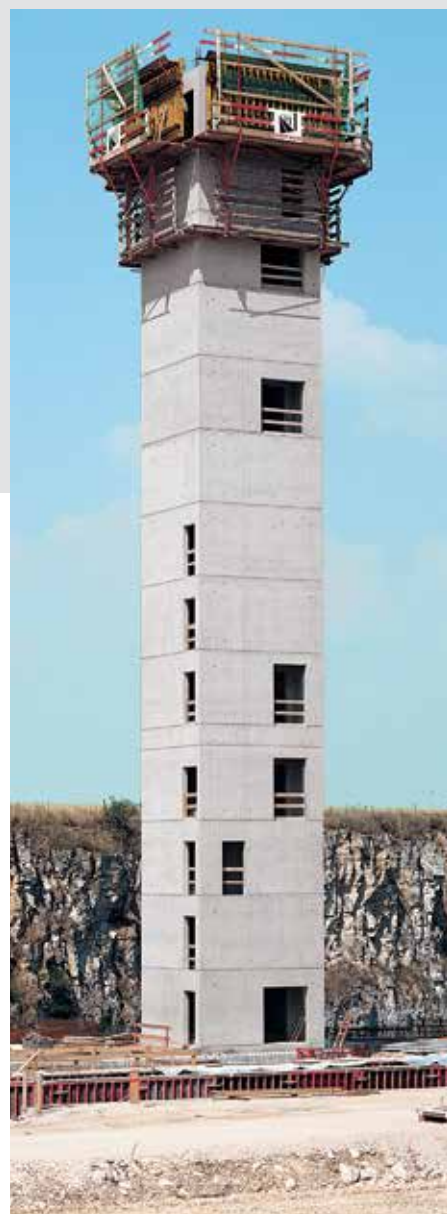
43,50 m højt tårn med synlig betonoverflade i bræddestruktur.
