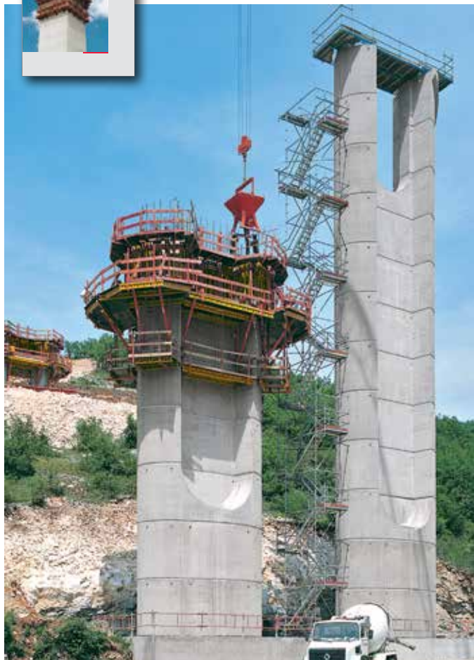
Motorvejsviadukt i Frankrig. Usædvanlig pillegeometri med høj overfladekvalitet. Forskallet med VARIO GT 24 og SKS klatringssystem.
