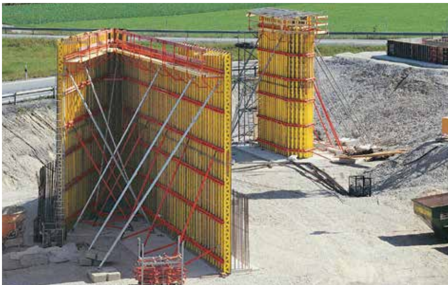
Vederlag og bropille med VARIO GT 24. Jernbanebro til den nye lufthavn i München.
