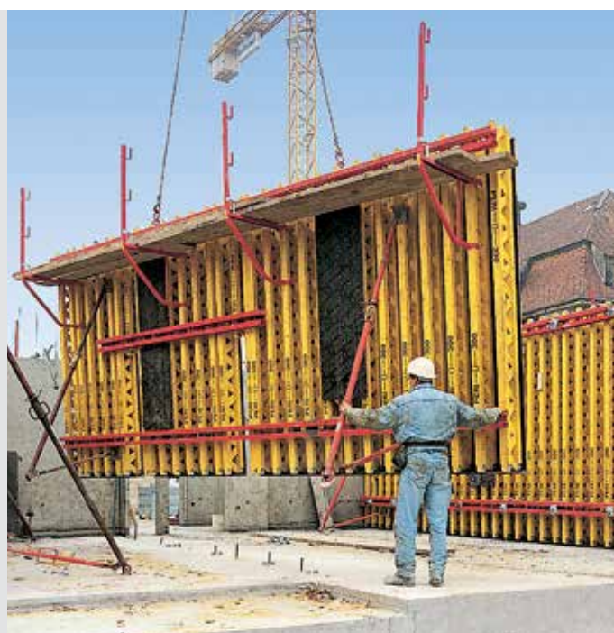
VARIO forme med støbekonsoller og elementstøtter, flyttes som én komplet enhed.
