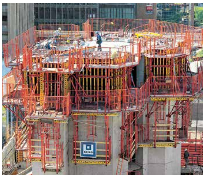
Højhus i Paris med VARIO GT 24 og klatringsystem CB 240.
