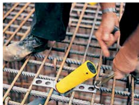
Forankringen monteres nemt på armeringen med tråd og tang.
