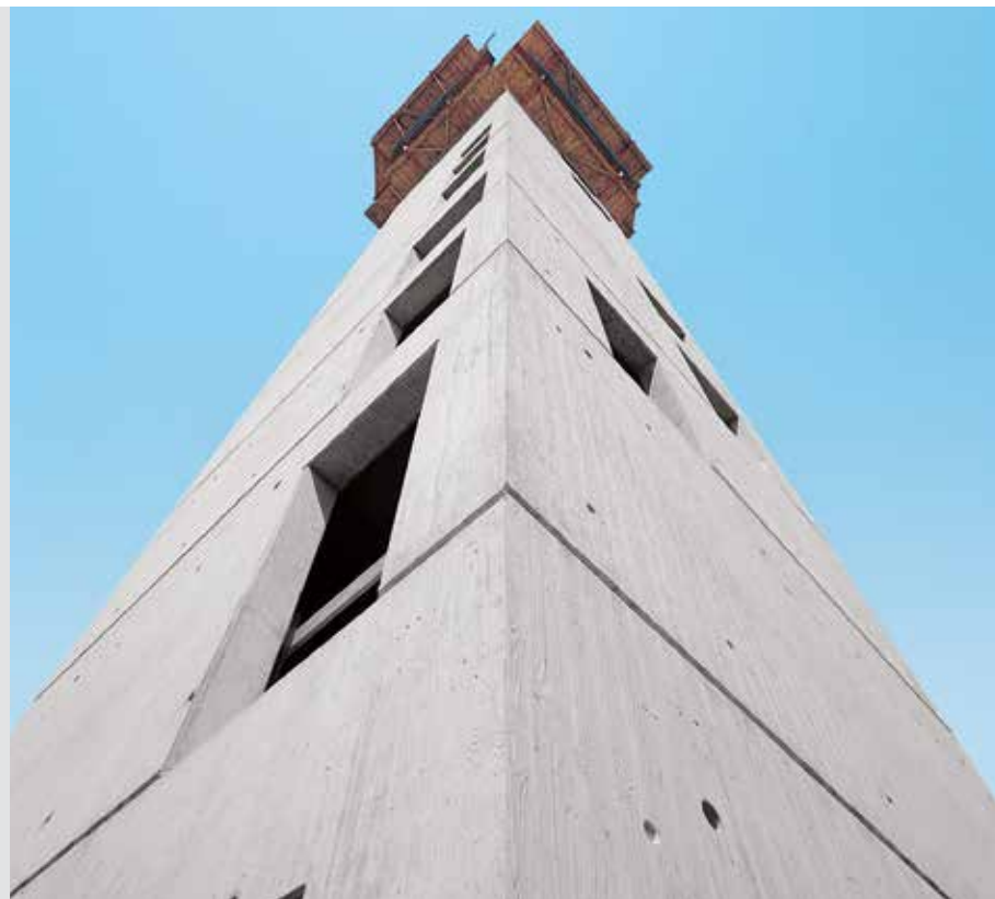
Meget flot synlig betonoverflade med ru, lodret bræddestruktur.
