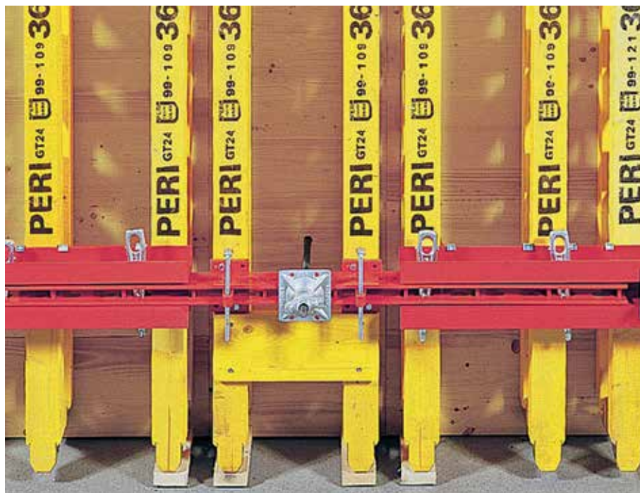
Trinløse tilpasninger med VARIO kobling VKZ.
