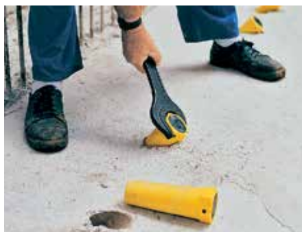
Fremløbskoblingen afmonteres med en fastnøgle SW 70.
