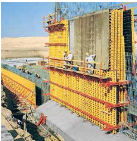
VARIO GT 24 til opførelsen af et rensningsanlæg med koniske vægge.
