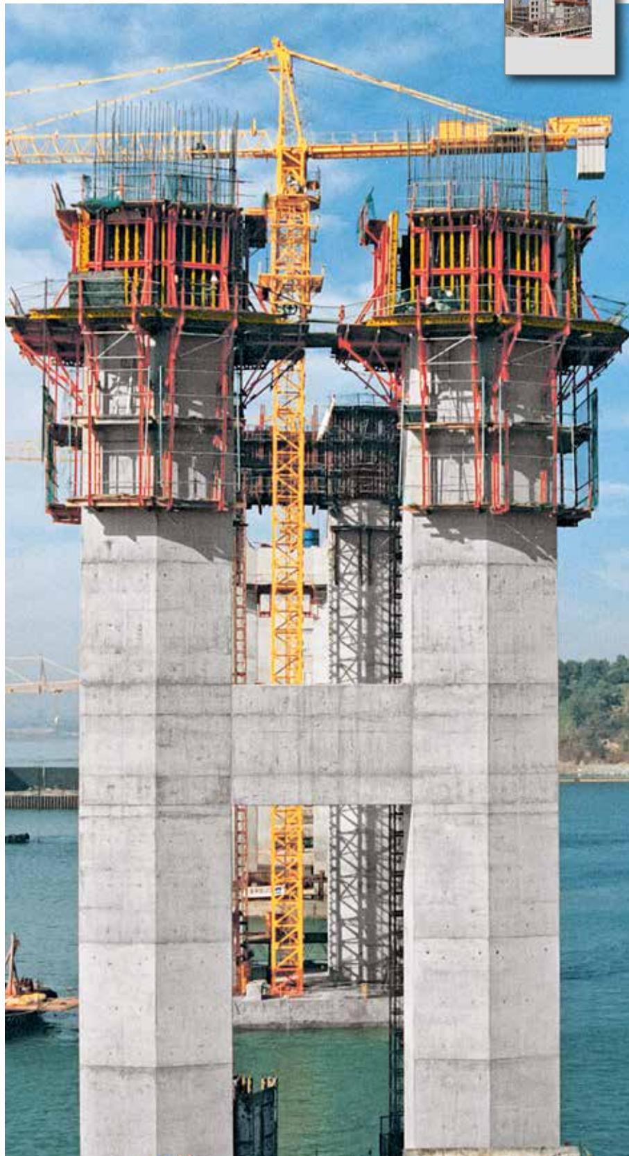
CB 240 med den trekant-formede konsol, gør det problemfrit, at arbejde både foran og bagved formen.
