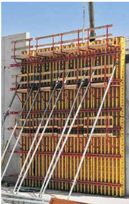
Forhøjet VARIO GT 24 forme til en kontorbygning.
