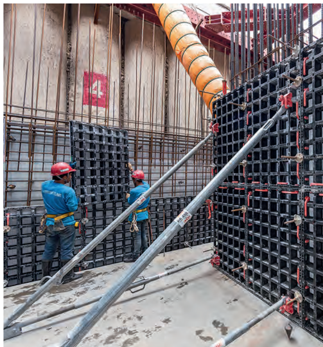
Lav vægt, små forskallingskassetter – disse fordele ved DUO udnyttes til fulde ved disse kældervægge
