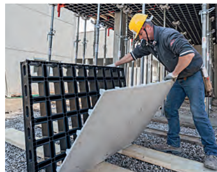
2. Fjern den beskadigede støbeplade.
