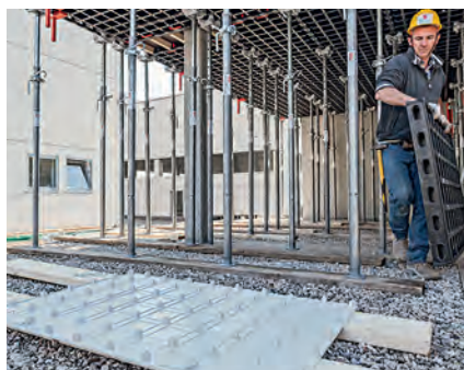
3. Gør den nye støbeplade klar.
