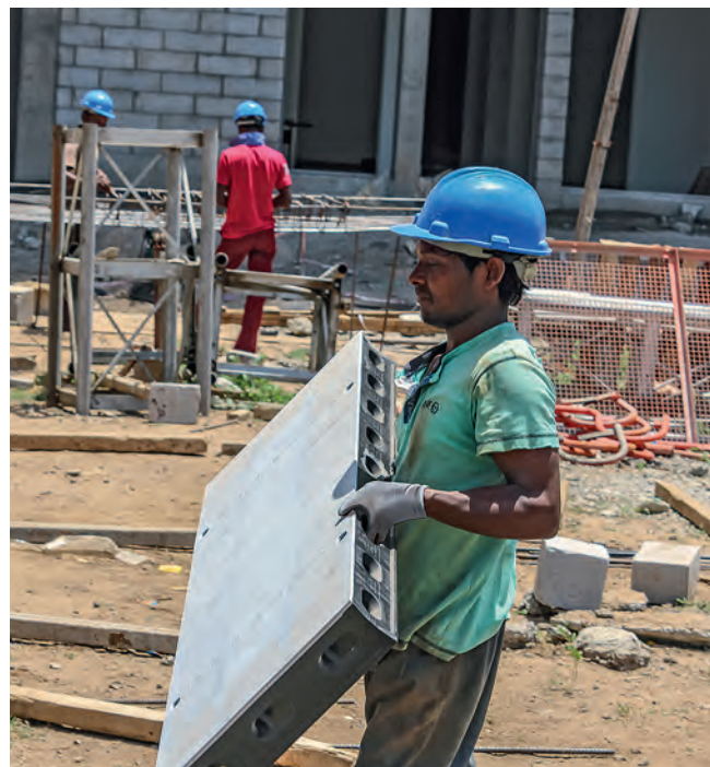
Hurtig forskalling og afforskalling i Indien
