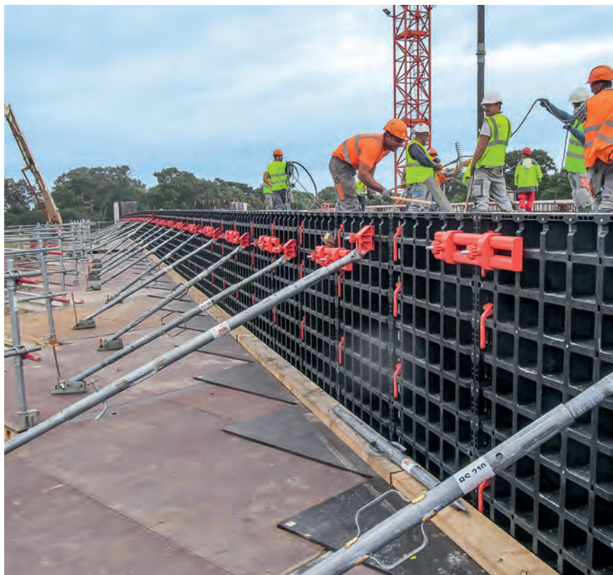
DUO er med små kassettestørrelser og enkel håndtering forudbestemt til forskalling af fundament.
