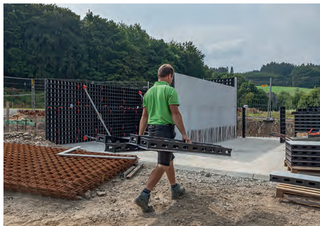
"Nybegyndere i forskalling" inden for have- og landskabsindretning bruger DUO til forskalling af løsvare-bokse
