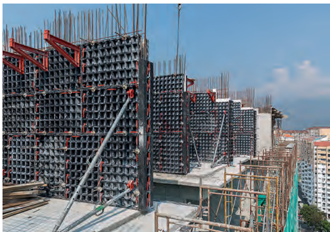
Vellykket første brug af den lette systemforskalling til fremstilling af vægsektioner
