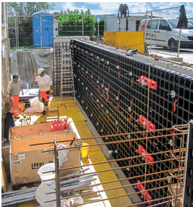
Om- og tilbygning uden kran – perfekt løst med DUO
