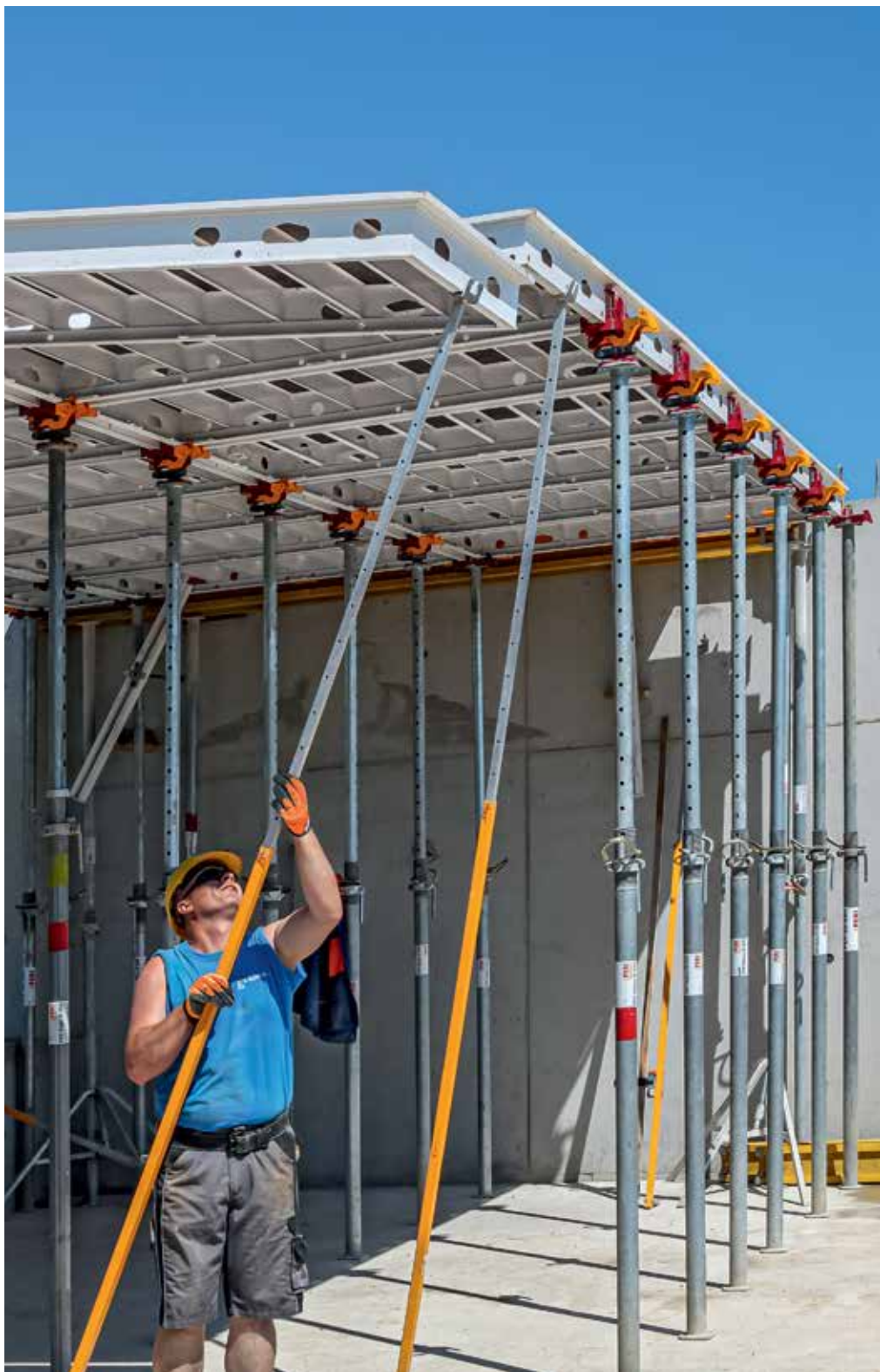
Forskallingsgaflen kan bruges til at forskalle dækhøjder op til 3,80 m på en sikker måde.
