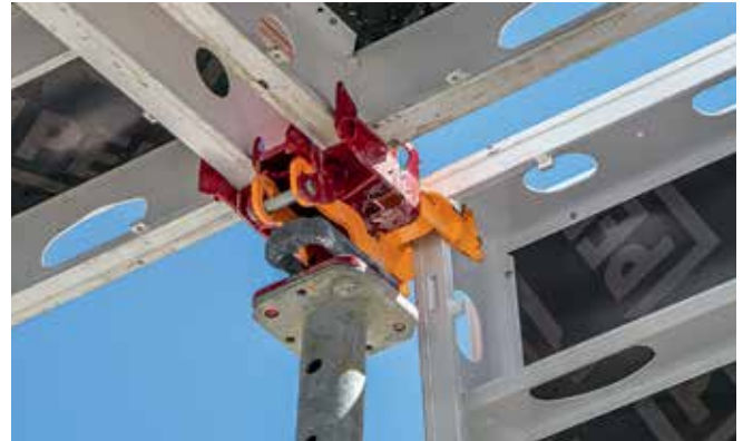
Takket være tænderne på støtte- og sænkehovederne, er kassetterne automatisk sikret mod løft, efter de er sat i.
