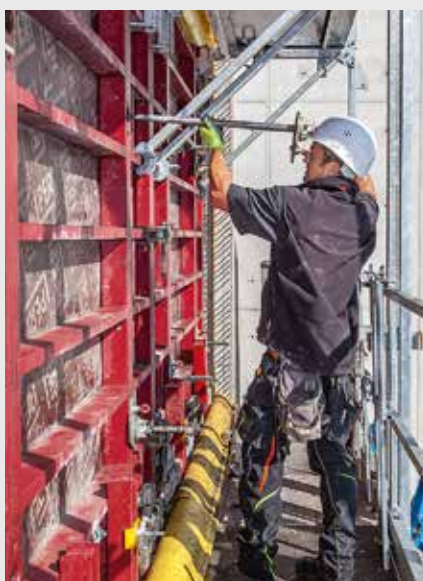
Alle ankre er lette at komme til, den gule gummilæbe beskytter formen mod tilsmudsning.
