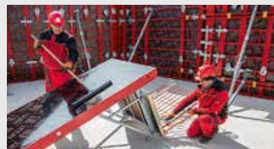
Arbejdsplatformene monteres på formen med den pågældende bredde og bliver også på forskallingen ved midlertidig opbevaring.
